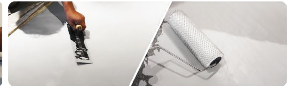
STEP 2 : MOISTURE BARRIER
