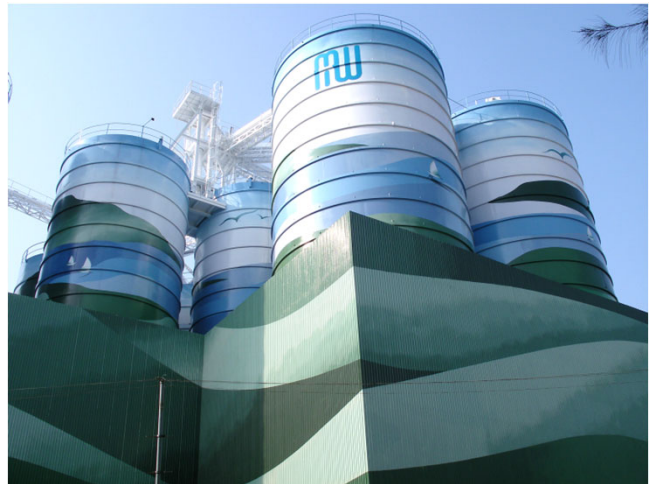
▲ Tai Po Silo
