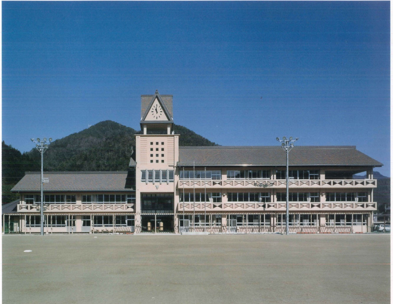
上麻生中学校(岐阜県) 設計/大建設株式会社
