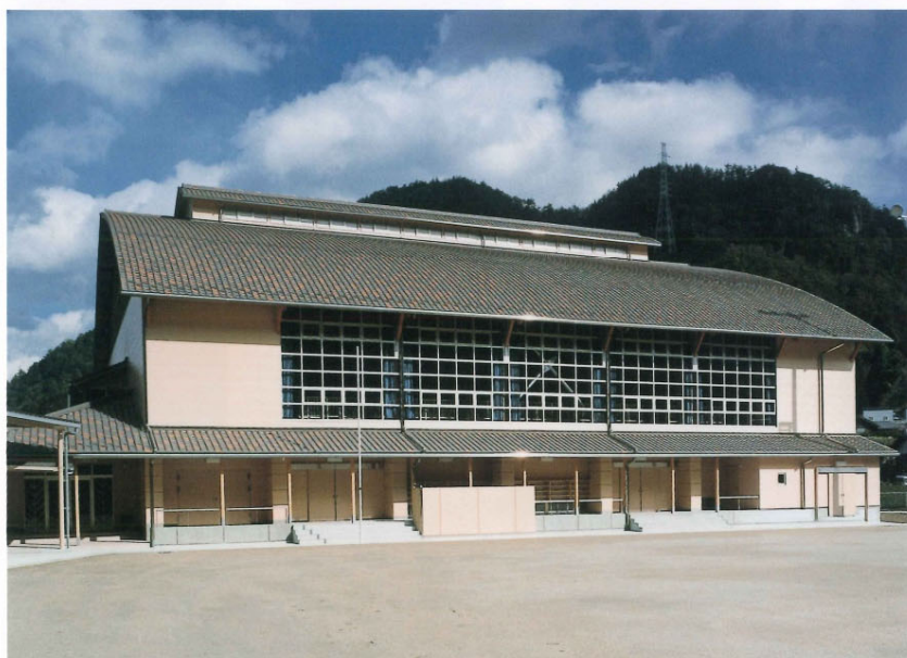
上麻生中学校体育館(岐阜県) 設計/大建設株式会社
