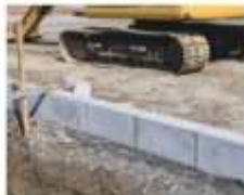
外構ブロック
