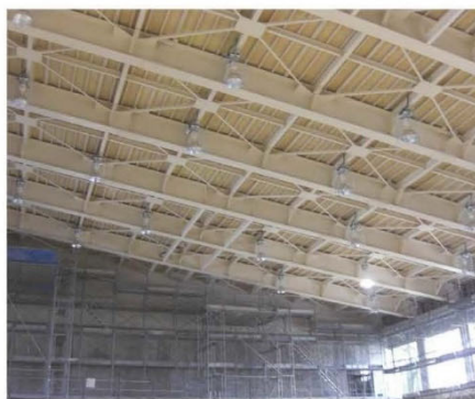
体育館 鉄骨梁
