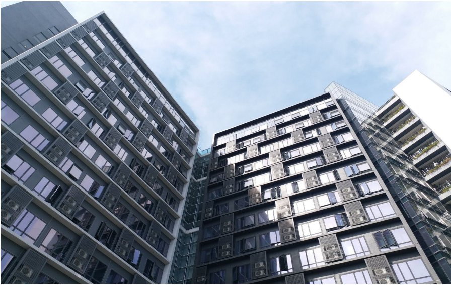
VTC Student Dormitory, Tsing Yi 職業訓練局學生宿舍, 青衣
